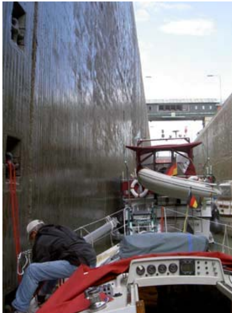
Inne i en 23 meter hög sluss.
